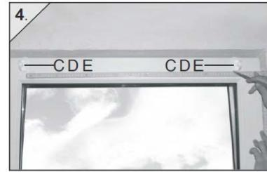
4. Τοποθετήστε τα συστήματα συγκράτησης (C, D, E) στο πλαίσιο του παραθύρου στο ύψος που θέλετε να τοποθετήσετε το στόρι και ευθυγραμμίστε τα. Σημειώστε τις θέσεις με μολύβι.
