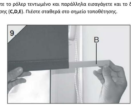
8. Κρατήστε το ρόλερ τεντωμένο και παράλληλα εισαγάγετε και το δεξιό σύστημα συγκράτησης (C,D,E). Πιέστε σταθερά στο σημείο τοποθέτησης.
