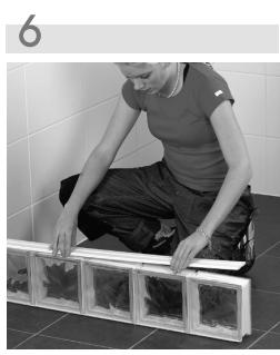
Βάλτε την κόλλα Block Lock στο οριζόντιο προφίλ και τοποθετήστε το στην πρώτη στρώση υαλότουβλων.
