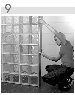
Αυτό το βήμα ολοκληρώνει την κατασκευή του τοιχώματος. Αν το τοίχωμα δεν ολοκληρώθηκε με τούβλα τελειώματος, αυτό μπορεί να γίνει με προφίλ U-τελειώματων ή με υάλινα στοιχεία.
