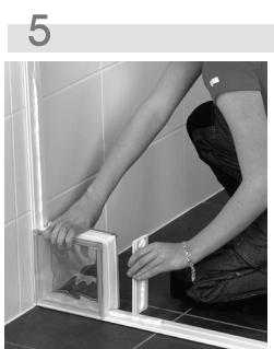
Τοποθετήστε το κάθετο προφίλ στο υαλότουβλο. Επαναλάβετε τα βήματα 4, 3 και 5.
