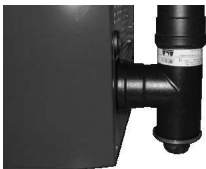
Fig. 22 - Καθαρισμός αγωγού καυσαερίων
